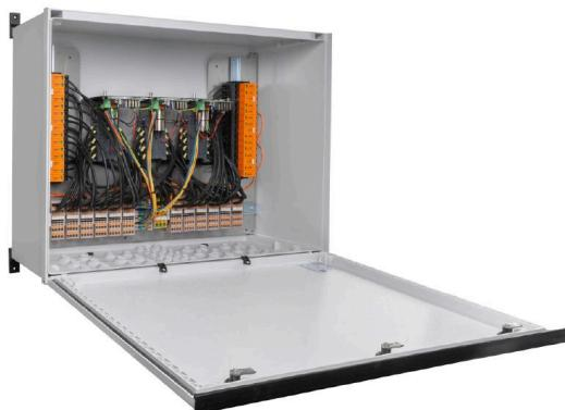
Для безопасного удаленного выключения Фотоэлектрические системы на крышах могут требовать наличия устройства разъединения в точке ввода проводов в здание, подключенное к его электроэнергетической системе. Благодаря этому пожарная бригада может проводить работы по тушению в чрезвычайных ситуациях без излишнего риска. После восстановления электропитания пожарный переключатель фотоэлектрической системы Next автоматически повторно подключает фотоэлектрические нити.
