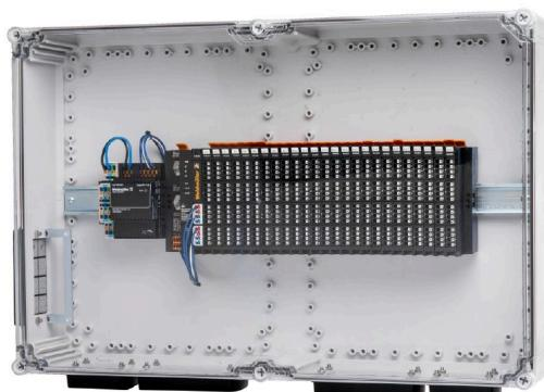
단극 차동 전압 측정용 CVM 박스는 고객 사양에 따라 조립되며 Plug & Play 솔루션을 사용하여 현장에서 빠르고 쉽게 설치할 수 있습니다. Weidmüller의 추가적인 엔지니어링 서비스는 안전하고 포괄적인 프로젝트 구현을 지원합니다. 전기 분해 스택의 수명은 수소 제조의 경제 효율에 매우 중요합니다. CVM 박스는 개별 셀의 차동 전압을 모니터링하여 시스템 효율을 높이는 데 결정적인 기여를 합니다. 데이터 분석을 통해 시스템을 감시할 수 있으며, 사용자는 언제든 기술 상태를 확인할 수 있고, CVM 박스를 사용하여 편차를 인식하고 사전에 정비 및 유지보수를 계획할 수 있습니다.
