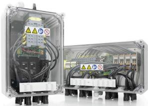
安全なリモートシャットダウン用 屋上の太陽光発電システムは、ケーブルが建物内に引き込まれた後の建物内の電力網との接続点で遮断装置が必要になることがあります。これにより、消防団は、不必要的危険を冒すことなく、緊急時の活動を行うことができます。電源が復旧すると、PV Next Fireman Switch が自動的にPVストリングを再接続します。
